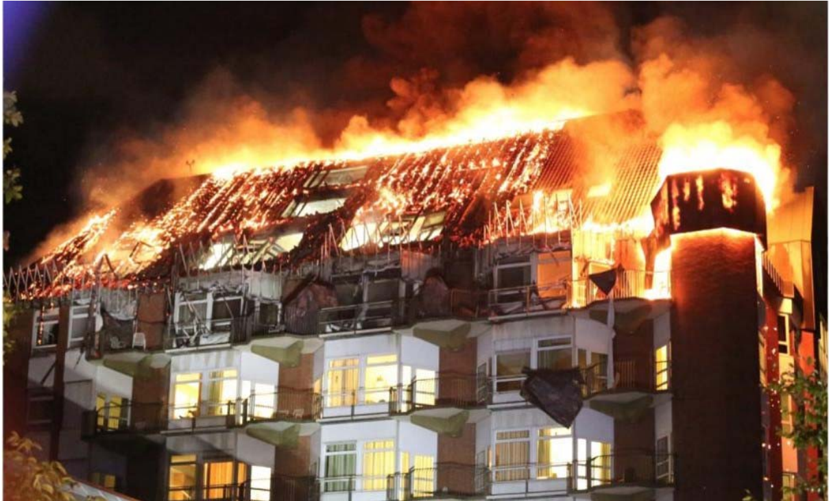
Kann der Brandschutz in unseren neuzeitlichen Bauwerken noch gewährleistet werden? (Foto: BF Bochum).
